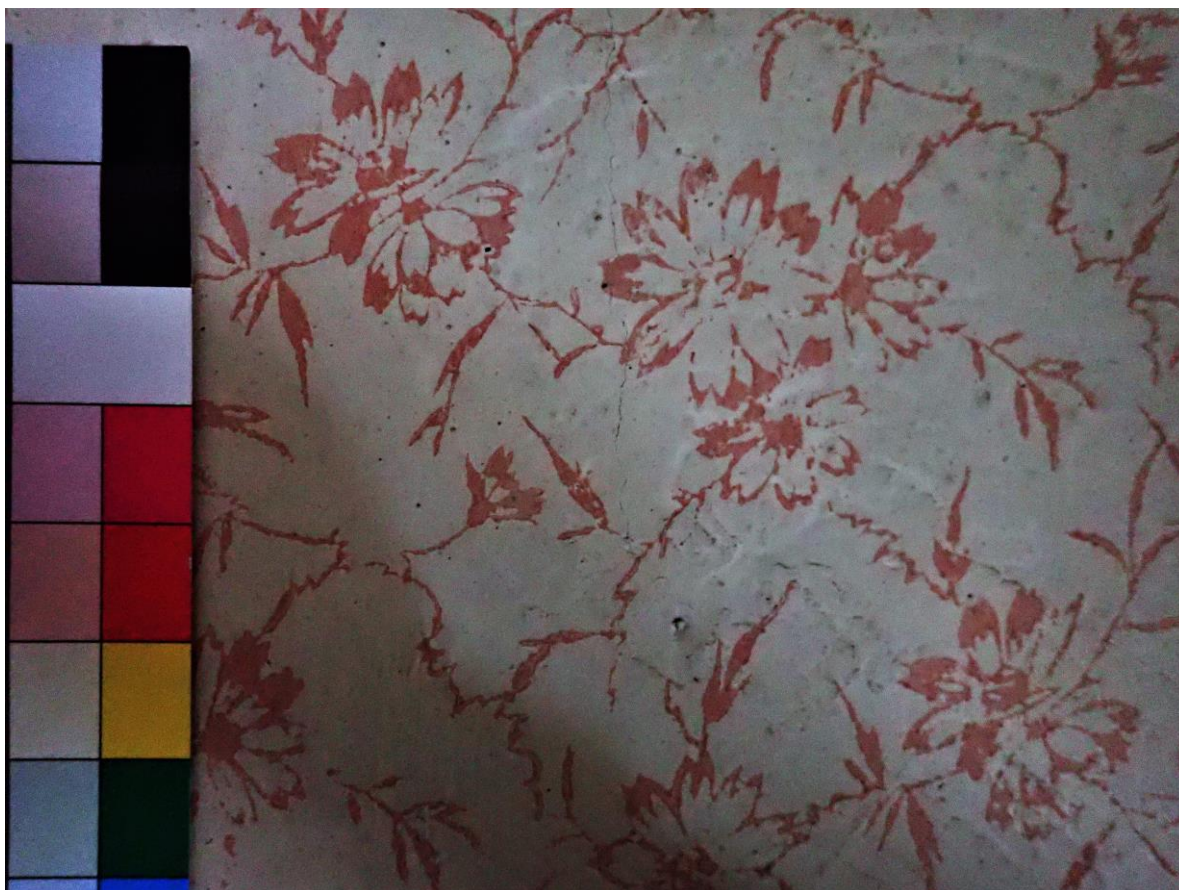
Současný světle žlutý nátěr s červeným válečkovým dekorem
