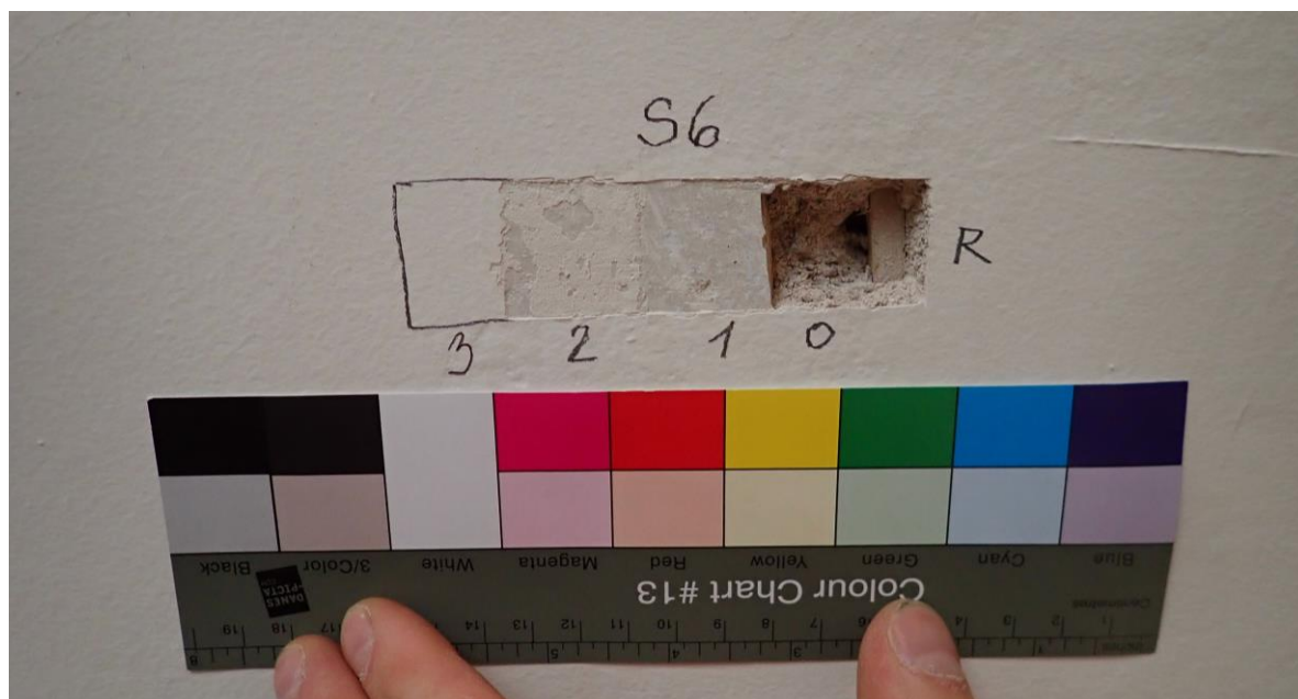
Sonda S6 v ploše stropu: R- dřevěné podbití s rákosovou armaturou, 0- omítka, 1- bílý nátěr, šedá, 2- bílá, 3- současný bílý nátěr
