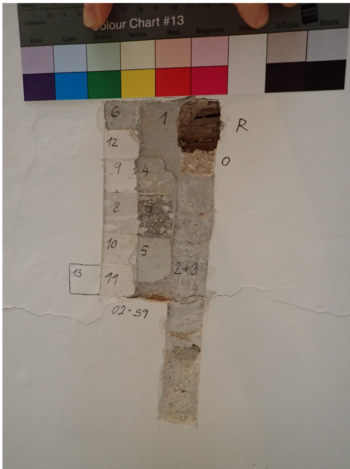
Sonda S9 v ploše stropu: R- dřevěné podbití s rákosovou armaturou, 0- omítka, 1- bílý nátěr, šedomodrá, 2- bílá, 3- světle šedá, 4- šedá s fragmenty okru, 5- světle zelená, 6- šedá, 7- tmavší šedá, 8- světle šedá, 9- bílá, 10- lomená bílá nažloutlá, 11- štuk, 12- bílá, 13- současný bílý nátěr
