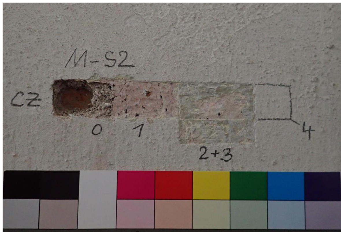
Sonda S2 v ploše stěny: CZ- cihelné zdivo, 0- omítka, 1- bílý nátěr, růžová, 2- světle zelená, 3- světle šedá, 4- současný bílý nátěr
