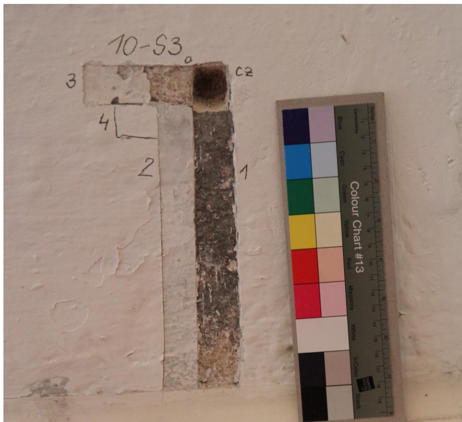
Sonda S3 v ploše stěny- sokl: CZ- cihelné zdivo, 0- omítka s fragmenty bílé a červené, 1- černá, 2- šedomodrá, 3- lomená bílá, 4- současný bílý nátěr
