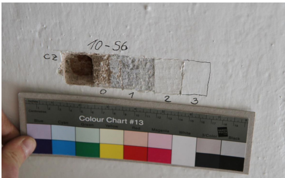
Sonda S6 v ploše klenebního pásu: CZ- cihelné zdivo, 0- omítka, 1- bílý nátěr s fragmenty šedomodré, 2- lomená bílá, 3- současný bílý nátěr
