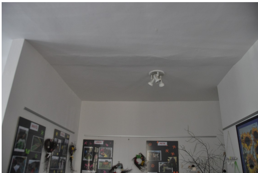
Nejdek, dům čp. 238 - výstavní sál, stopy po odstraněné části střední traktové zdi
