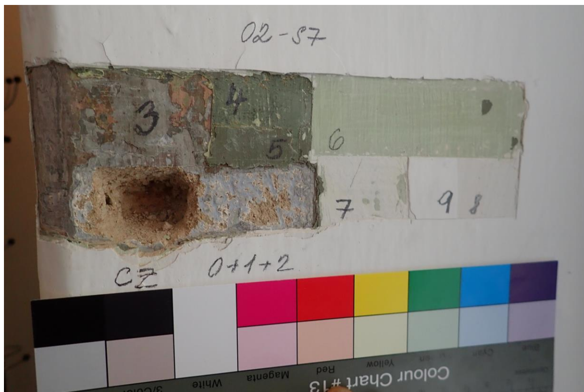
Sonda S7 v ploše okenního ostění: CZ- cihelné zdivo, 0- omítka, 1- bílý nátěr, 2- modrá, 3- šedá s fragmenty hnědofialové, šedé, hnědé a oranžové, 4- světle zelená, zelená, 5- zelená, 6- světle zelená, 7-bílá, 8- bílá, 9- současný bílý nátěr
