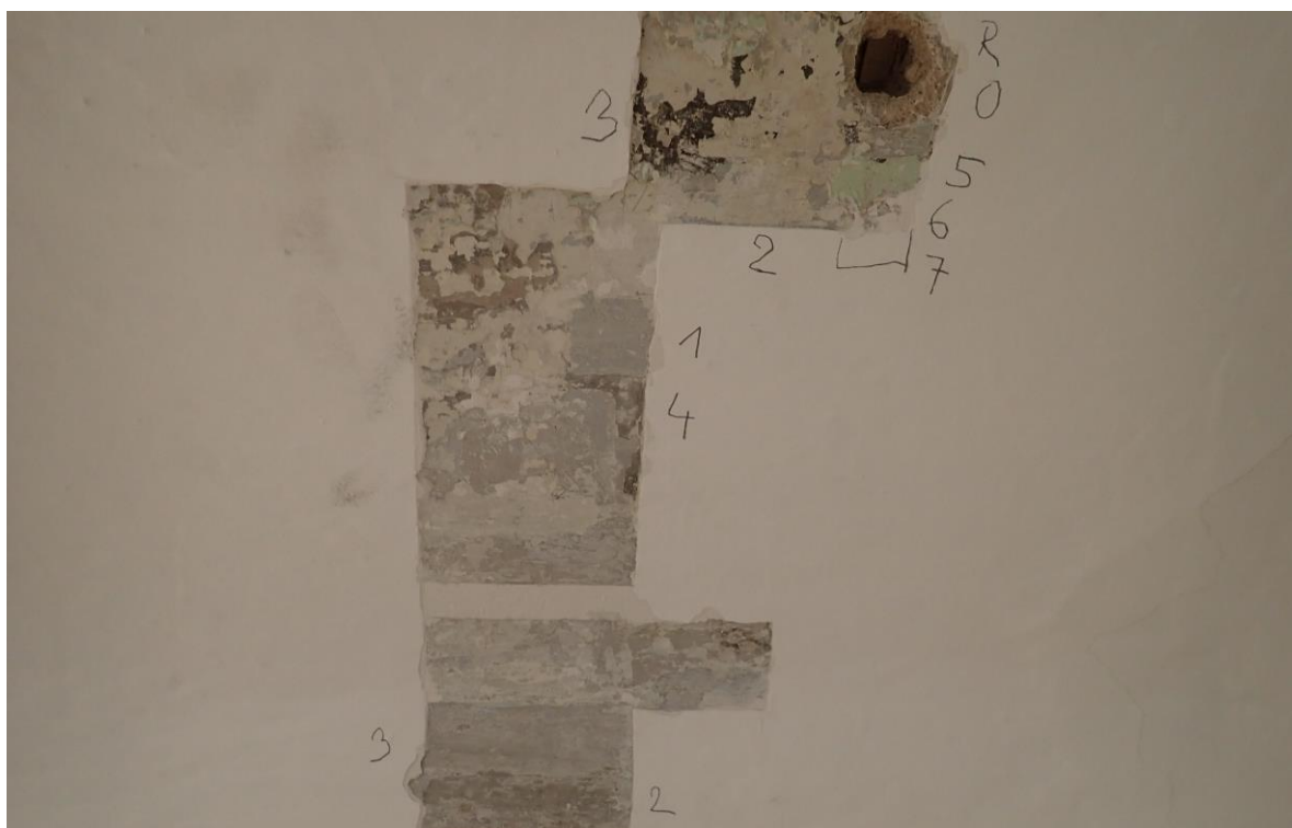
Sonda S6 v ploše stropu: R- dřevěné podbití s rákosovou armaturou, 0- omítka, 1- bílý nátěr, šedomodrá, 2- bílá, 3- fragmenty černé, hnědé, 4- šedá, 5- světle zelená, 6- bílá, 7- současný bílý nátěr
