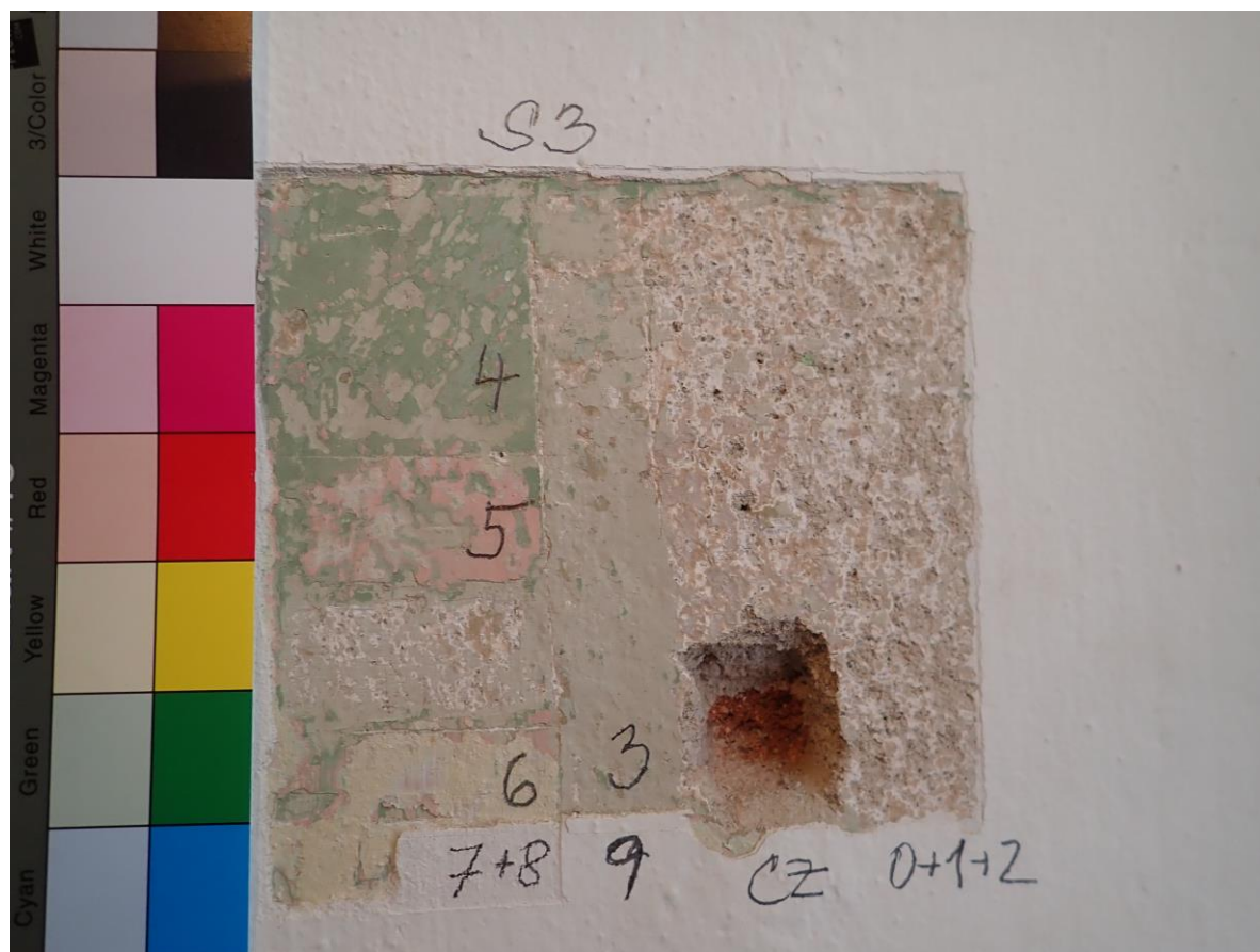
Sonda S3 v ploše stěny: CZ- cihelné zdivo, 0- omítka, 1- bílý nátěr, 2- světle hnědá, 3- béžovozelená, 4- zelená, 5- oranžová, 6- světle žlutá, 7- štuk, 8- současný bílý nátěr
