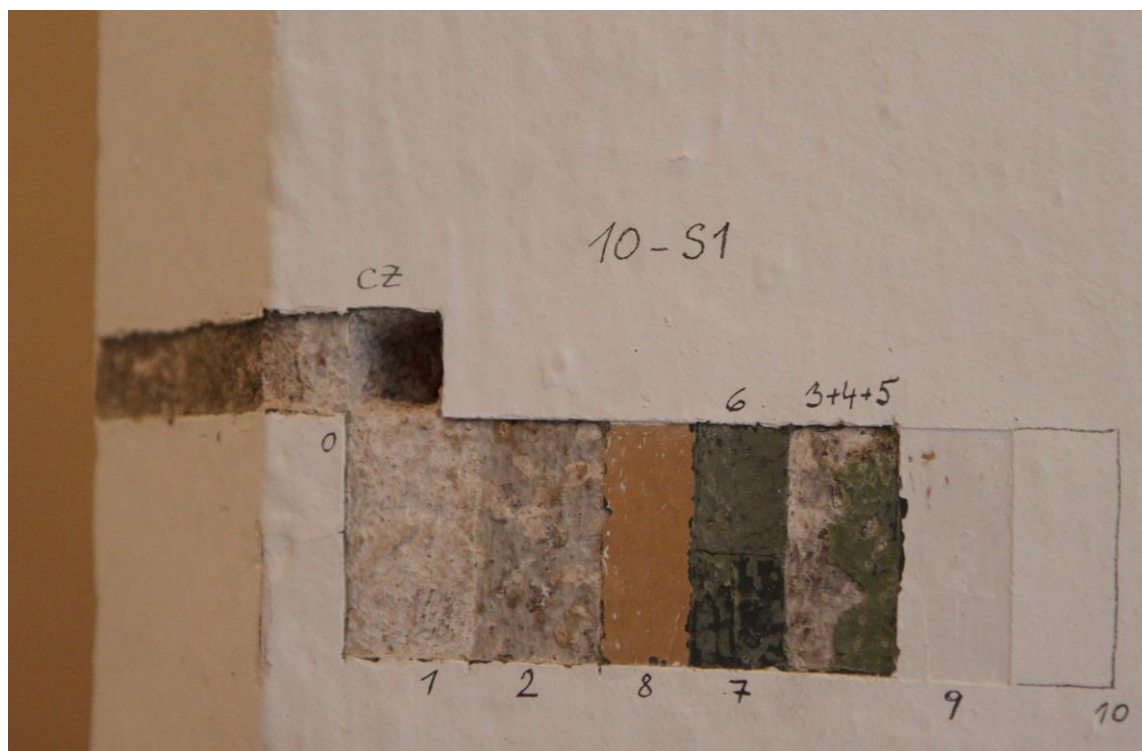
Sonda S1 v ploše stěny: CZ- cihelné zdivo, 0- omítka, 1- bílý nátěr s fragmenty okru, 2- šedá, 3+4+5- světle zelená, zelená, tmavší zelená, 6- zelená, 7- černá, 8- okr, 9- bílá, 10- současný bílý nátěr
