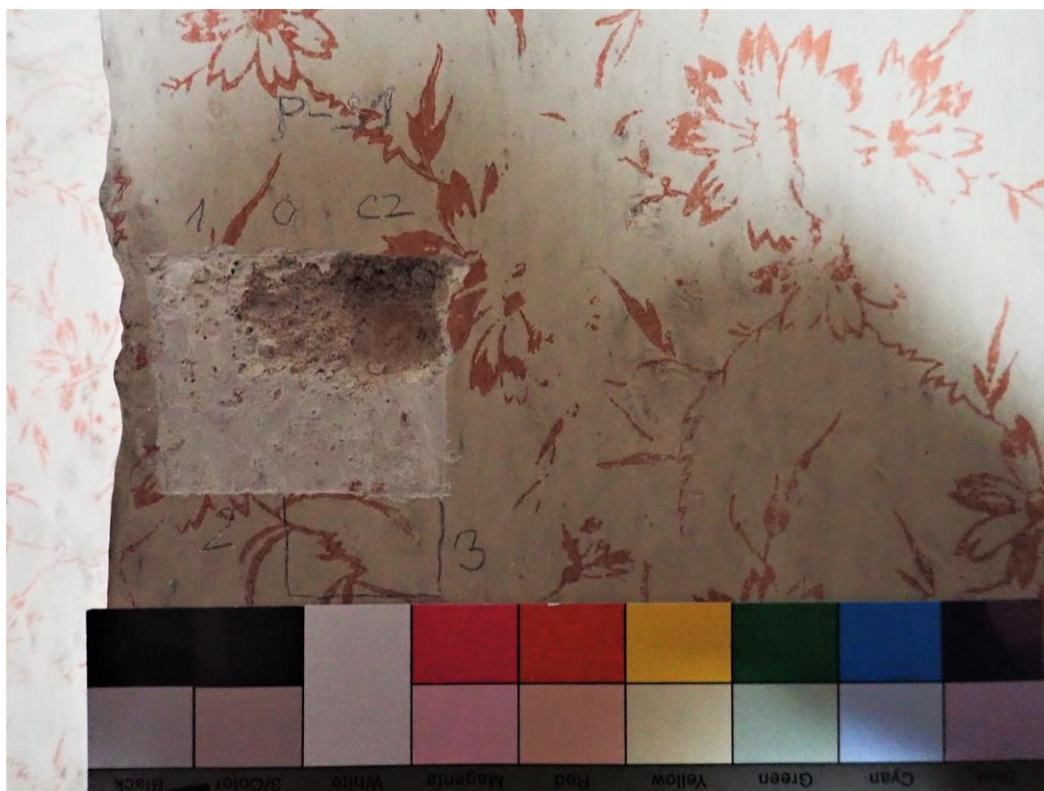
Sonda S1 v ploše stěny: CZ- cihelné zdivo, 0- omítka, 1- bílý nátěr, 2- světle šedá, 3- současný světle žlutý nátěr s červeným válečkovým dekorem
