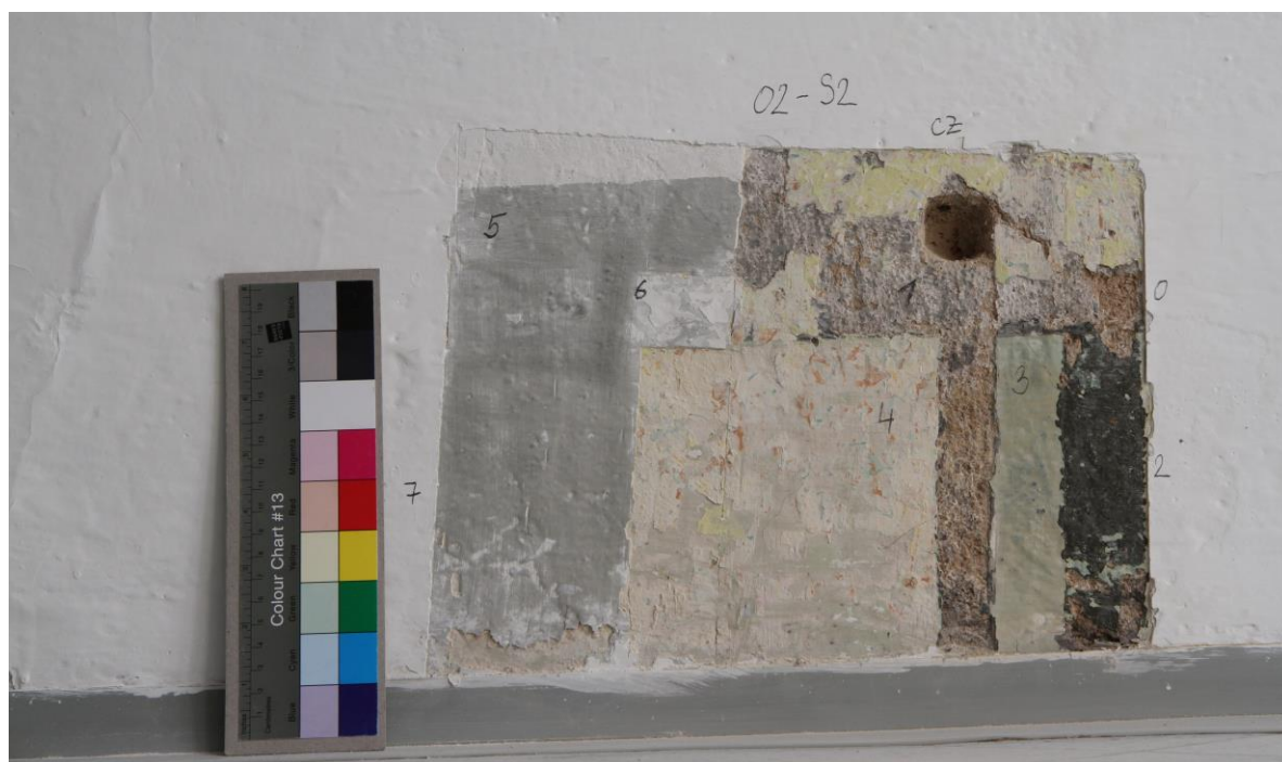
Sonda S2- v soklové části: 0- omítka s fragmenty hnědé, 1- bílý nátěr, světle šedá, tmavší šedá, 2- černá, 3- světle zelená, 4- světle žlutá dekorovaná válečkem oranžové a zelené barvy, 5- šedý sokl a bílá stěna, 6- bílá, 7- současný bílý nátěr
