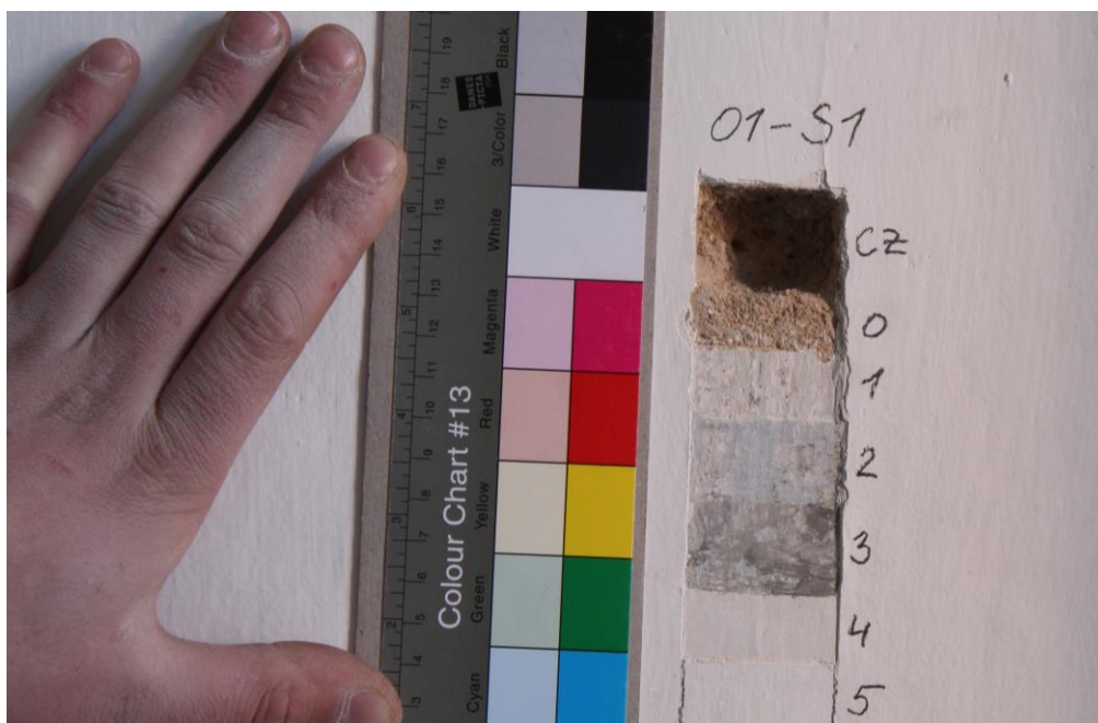
Sonda S1- v ploše stěny: CZ- cihelné zdivo, 0- omítka, 1- bílý nátěr s fragmenty šedé, 2- světle modrá, 3- šedá s fragmenty černé, 4- bílá, 5- současný bílý nátěr
