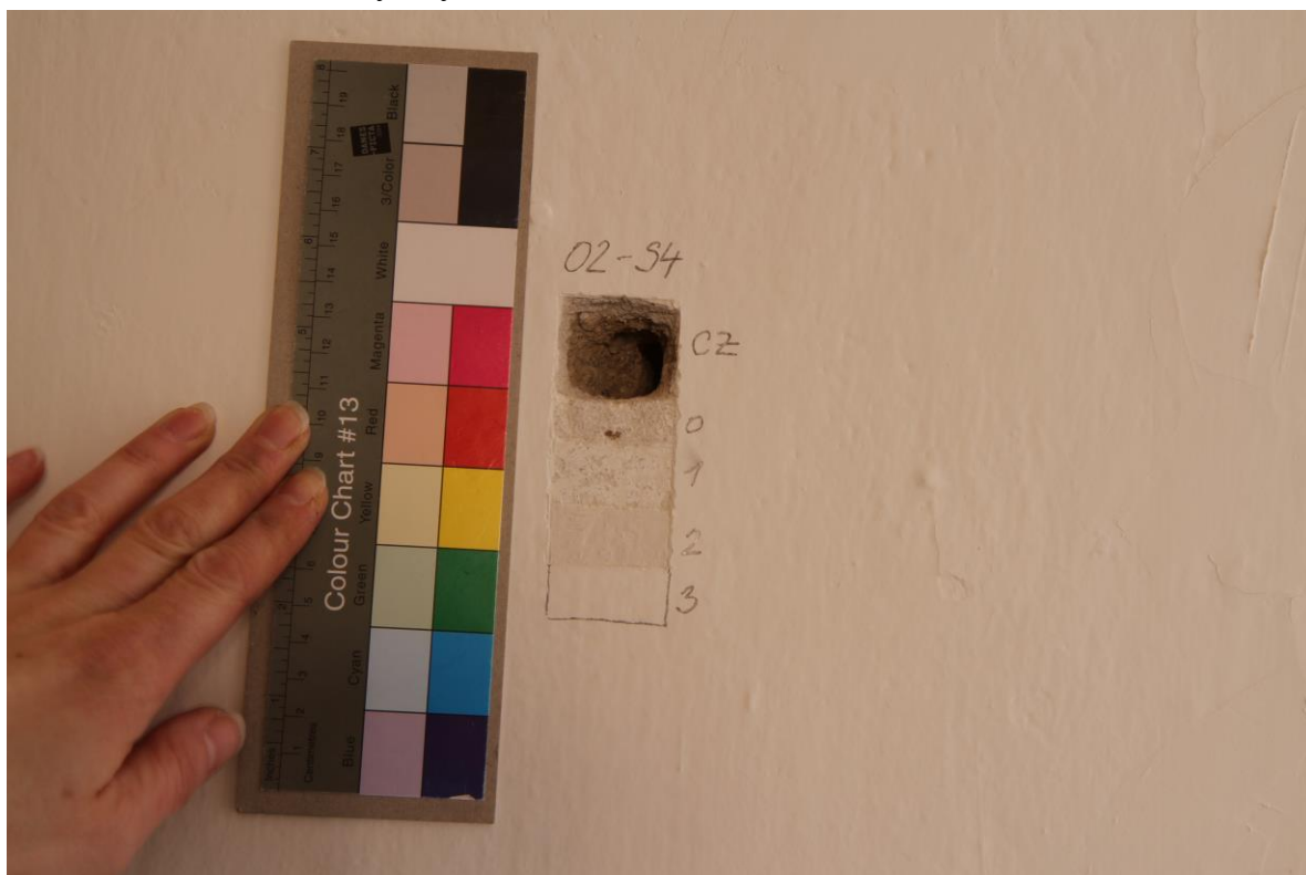
Sonda S4 v ploše stěny: CZ- cihelné zdivo, 0- omítka, 1- bílý nátěr, 2- lomená bílá, 3- současný bílý nátěr
