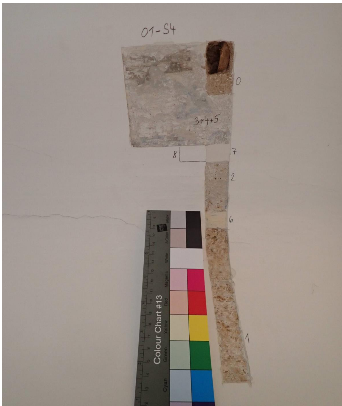
Sonda S4- v ploše stropu a fabionu: R- dřevěné podbití s rákosovou armaturou, 0- omítka, 1- bílý nátěr s fragmenty hnědé, 2- světle šedá, 3+4+5- bílá s fragmenty světle šedé, fragmenty světle modré a hnědé, 6- světle žlutá, 7- bílá, 8- současný bílý nátěr
