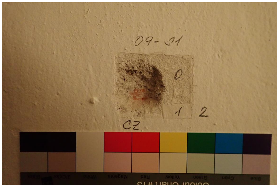
Sonda S1 v ploše stěny: CZ- cihelné zdivo, 0- omítka, 1- bílý nátěr, 2- současný bílý nátěr
