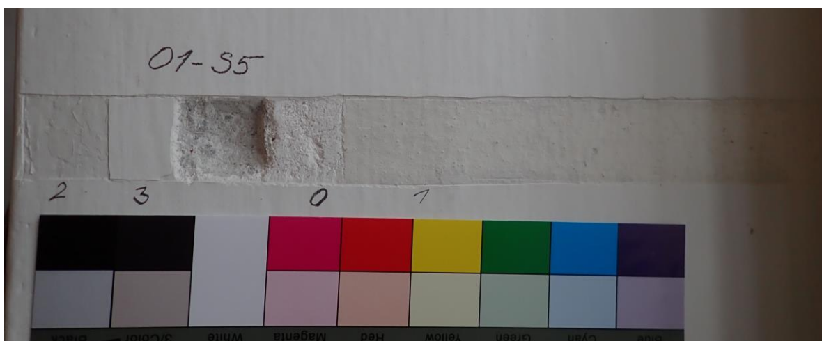
Sonda S5- v okenním ostění: 0- omítka, 1- bílý nátěr, 2- bílá, 3- současný bílý nátěr
