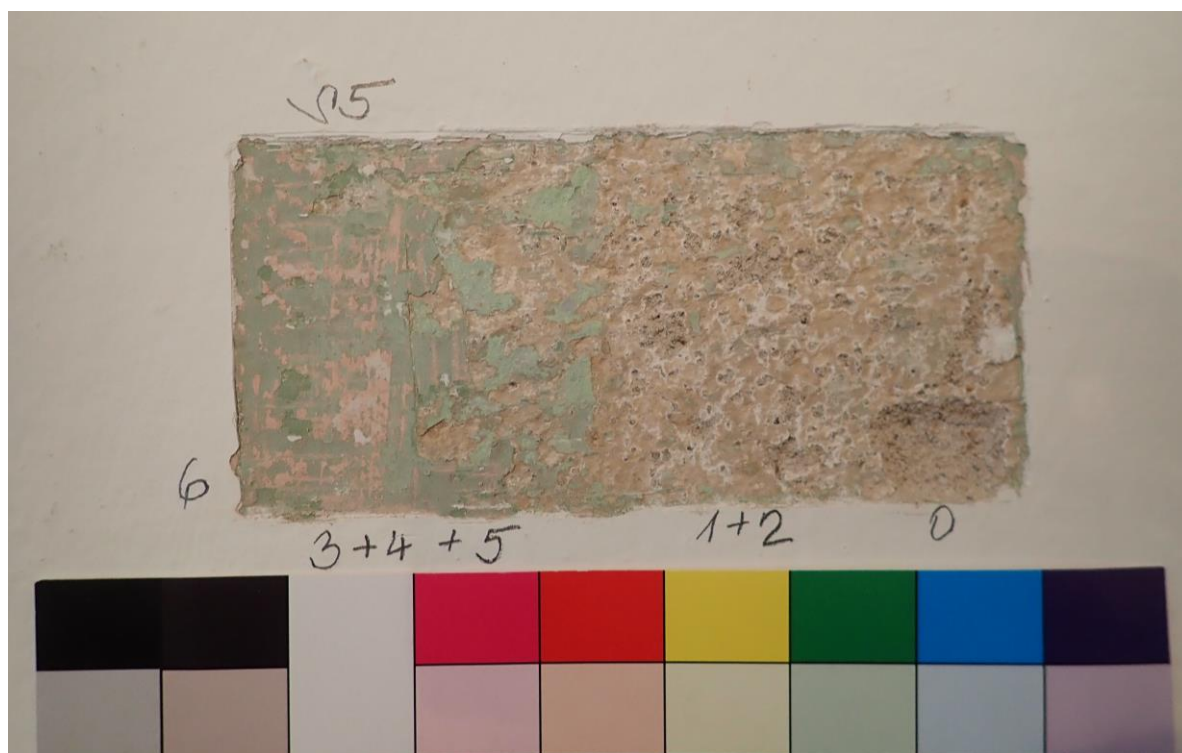
Sonda S5 v ploše stěny: 0- omítka, 1- bílý nátěr, 2- světle hnědá, 3- béžovozelená, 4- zelená, 5- oranžová, 6- současný bílý nátěr
