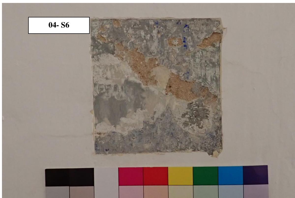
Sonda S6 v ploše stěny zaměřené na nejstarší dochovanou vrstvu malby: na bílé vrstvě fragmenty šedé, zelených a tmavě modré
