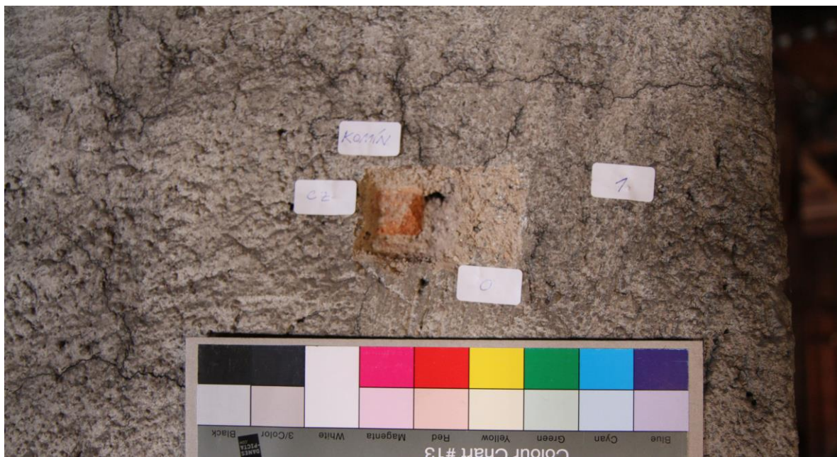
Sonda S1 v ploše stěny: CZ- cihelné zdivo, 0- omítka, 1- současný bílý nátěr
