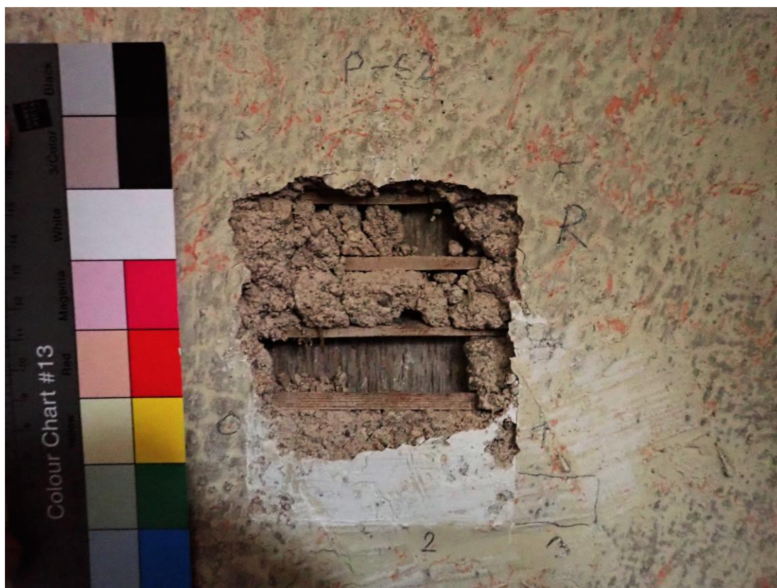
Sonda S2 v ploše stěny: R- dřevěné podbití s rákosovou armaturou, 0- omítka, 1- bílý nátěr, 2- světle šedá, 3- současný světle žlutý nátěr s červeným válečkovým dekorem
