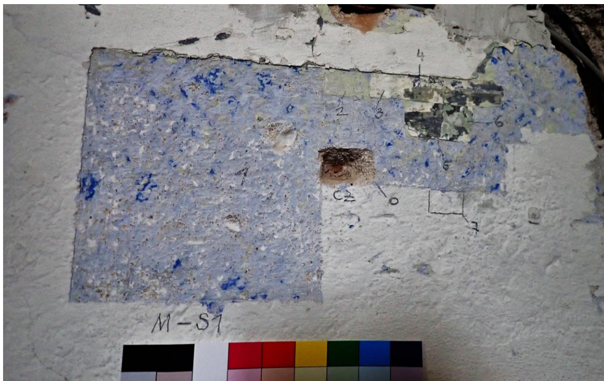
Sonda S1 v ploše stěny: CZ- cihelné zdivo, 0- omítka, 1- bílý nátěr, modrá s fragmenty tmavé modré, 2- světle zelená, 3- bílá, 4- světle hnědá, 5- tmavě šedá, černá, 6- zelená, 7- současný bílý nátěr
