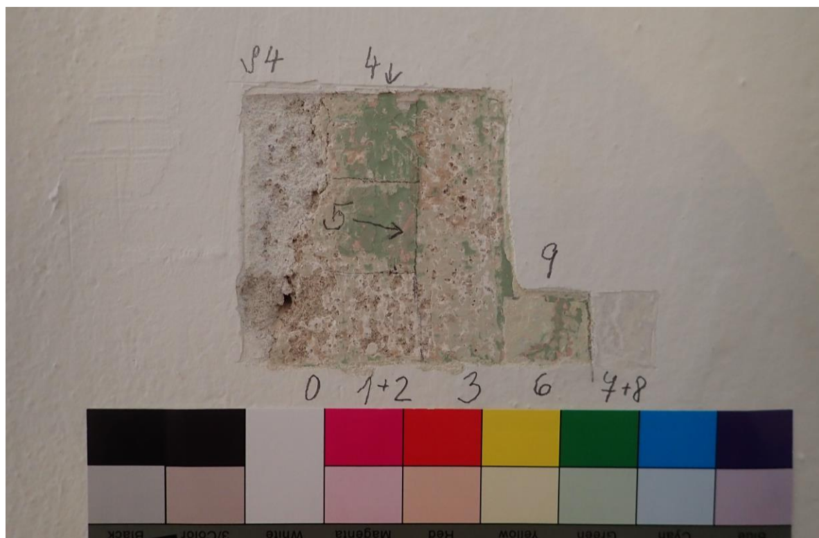
Sonda S4 v ploše stěny: 0- omítka, 1- bílý nátěr, 2- světle hnědá, 3- béžovozelená, 4- zelená, 5- oranžová, 6- světle žlutozelená, 7- štuk, 8- lomená bílá, 9- současný bílý nátěr
