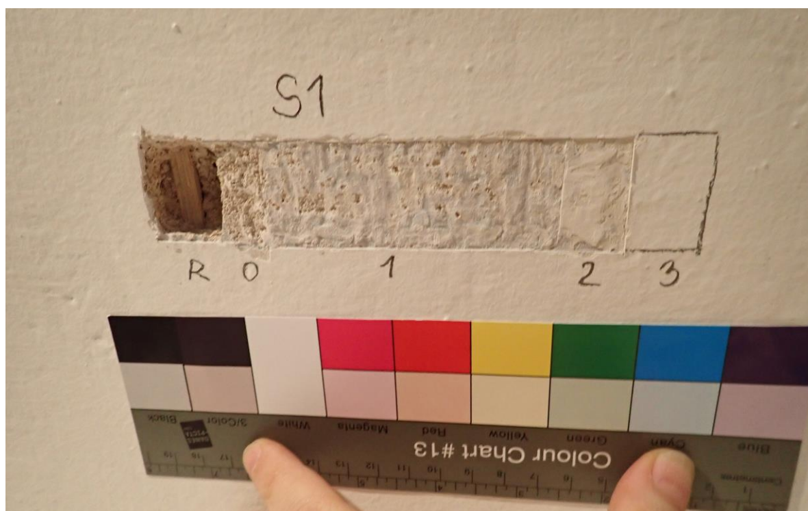
Sonda S1 v ploše stropu: R- dřevěné podbití s rákosovou armaturou, 0- omítka, 1- bílý nátěr, šedomodrá, 2- bílá, 3- současný bílý nátěr
