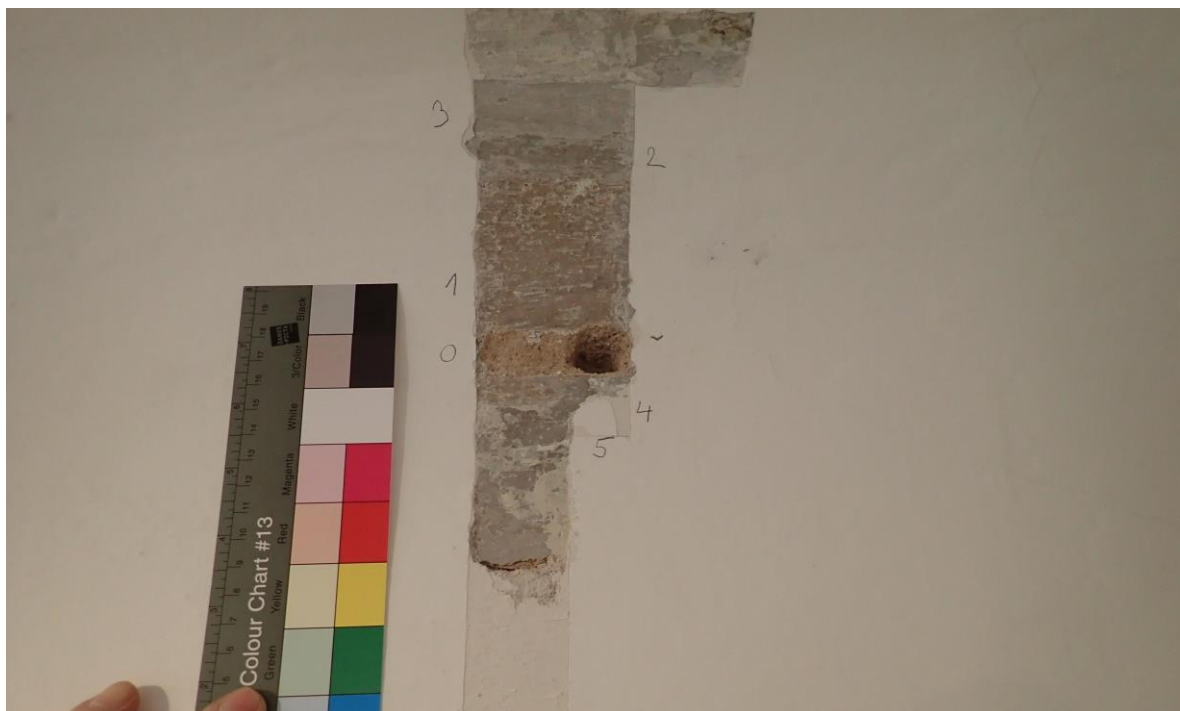
Sonda S5- v ploše fabionu: 0- omítka, 1- bílý nátěr, hnědá, 2- šedá, 3- tmavší šedá, 4- bílá, 5- současný bílý nátěr
